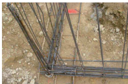
Nœud de chaînage - Continuité mécanique
